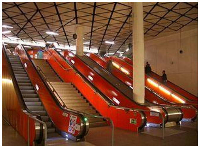
Foto 6. Välutrustad tunnelbanestation i Frankfurt (Willy Brandt Platz)
