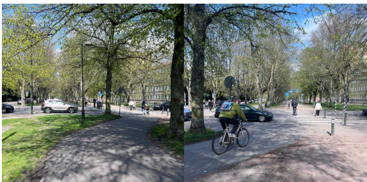
Figur 17. Snäv sväng som tvingar cyklisterna att sakta ner, trots detta kan det bli misskommunikation. Egna foton.
