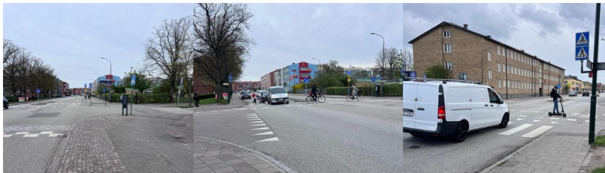
Figur 15. Bilder över Norra Grängesbergsgatan som visar ett fartgupp som är lite för långt ifrån cykelkorsningen och bilar som står i vägen vid tvära inbromsningar. Egna foton.
