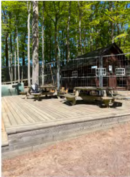
Fig 9: Upphöjd träterrass utan ramp eller kontrastmarkering. Fysisk barriär för rullstolsburna och personer med nedsatt rörlighet i Sofieros parkmiljö.
