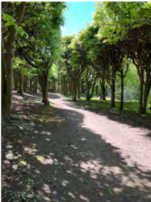
Fig 7: Stigen i Sofiero är ojämn med grus, småsten och synliga rötter, vilket gör det svårt att ta sig fram med rullstol. Lutningen och underlaget blir särskilt problematiskt vid regn och under höst och vinter, då det kan bli halt och lerigt. Miljön är inte anpassad för alla.
