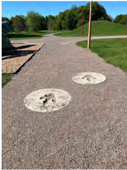
Fig. 5: Dinosaurierlekplatsens gångväg består av löst grus, vilket i sig kan försvåra framkomligheten för personer som använder rullstol eller andra hjälpmedel. Utöver detta finns upphöjda och oregelbundna markeringar (dinosauriefotavtryck) målade direkt i gångytan. Dessa skapar ojämnheter som ytterligare kan försvåra rörelse och riskera att orsaka obalans eller fastna med små hjul. Utformningen strider mot principerna om universell utformning, särskilt vad gäller enkelhet, jämnhet och användbarhet för alla.
