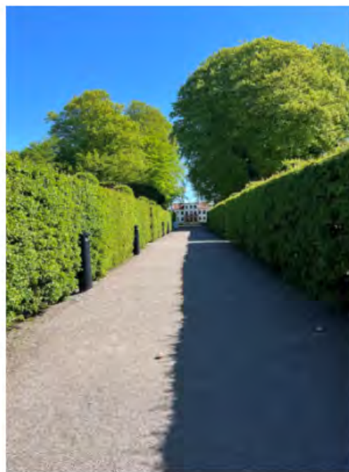
Figur 8 : Brett och platt passage med grusunderlag som i torrt väder ger god framkomlighet, men som kan begränsa rullstolsburna vid nederbörd.
